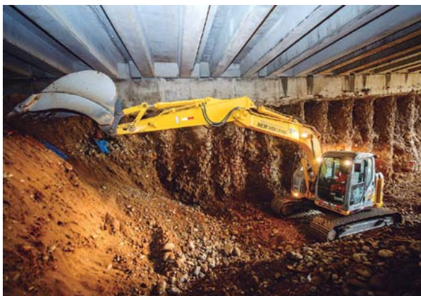
Excavación del Túnel del IVD Benavides (Perú).
