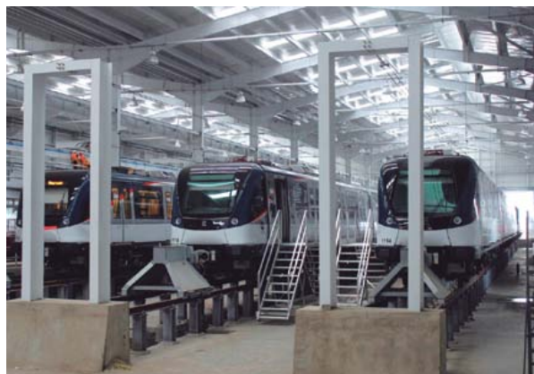
Línea Metro de Panamá. Foto: EFE/Consortio Lonea Metro
