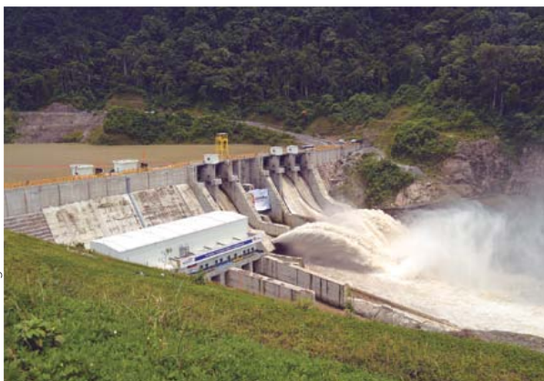
Planta Hidroeléctrica de Laúca (Ecuador).
